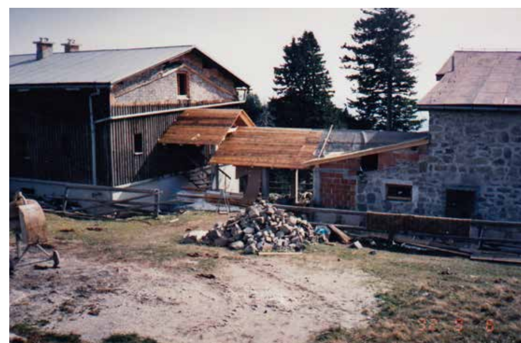
1992 Izgradnja veznega hodnika in dvig ostrešja za sobe
