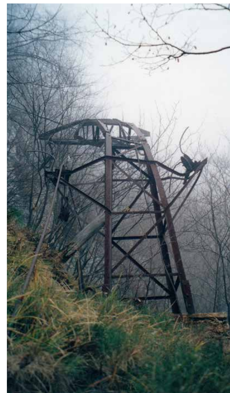
Skrivljen kovinski steber tovarne žičnice pod Pirčevo planino
